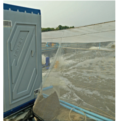
Os biofiltros BioGill operando em tanques de crescimento de camarão em um dos maiores produtores do mundo na Tailândia.
