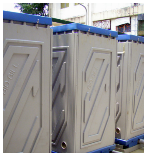
Reatores BioGill adaptados a uma ETE existente em Manila (Filipinas) para ampliar a redução de DBO e reduzir o consumo de energia.
